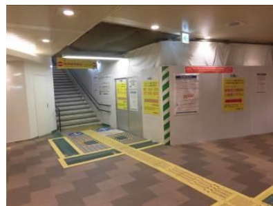
工事が進む本厚木駅上りホーム(新宿方面) 下り専用エスカレーター
